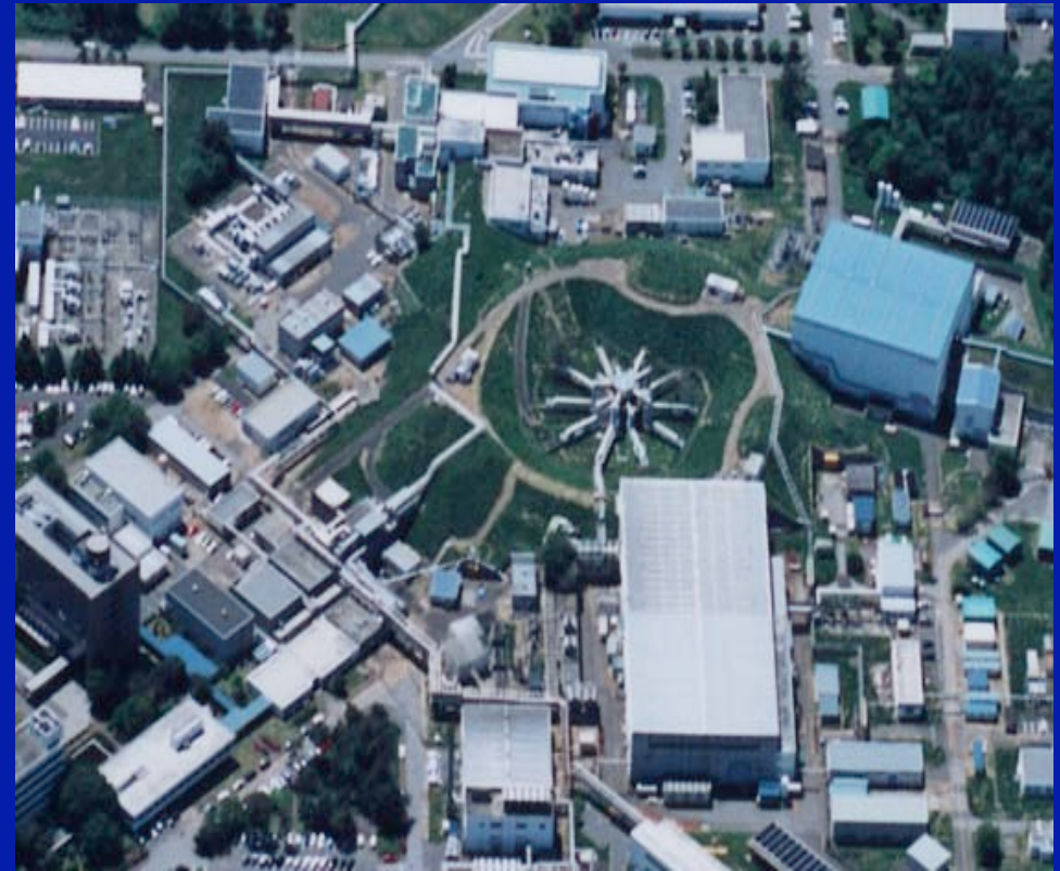
12GeV 陽子シンクロトロン 施設全景
